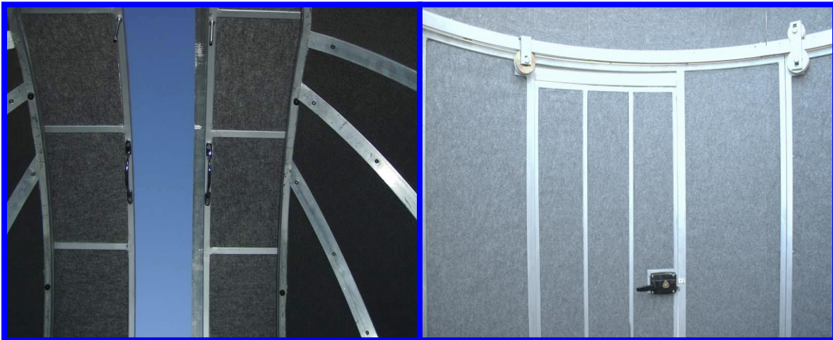
Ejemplo de aislamiento interno
