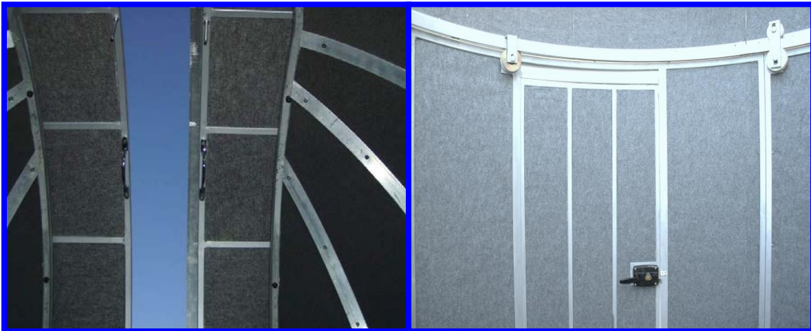
Ejemplo de aislamiento interno
