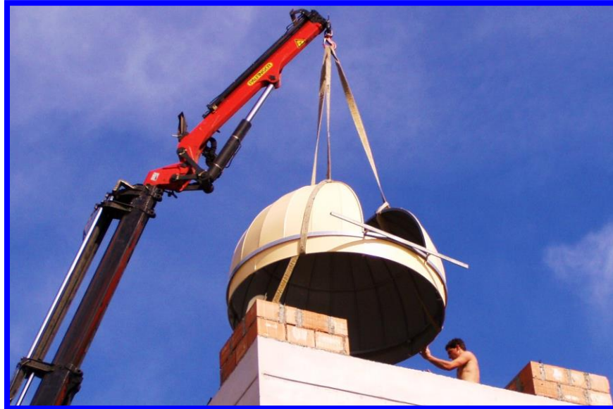
Ejemplo de instalación de una cúpula del diámetro 240cm sobre un techo
